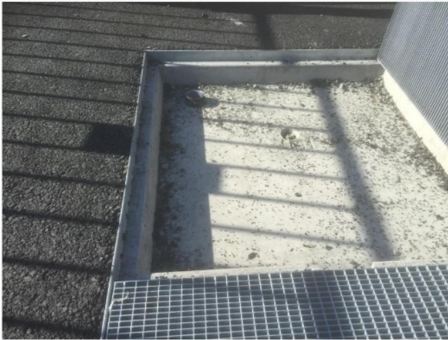
Granulatoppsamler. 2 kummer på 1x2m, dypde 200mm. Sluk i hver kum og renne imellom.
