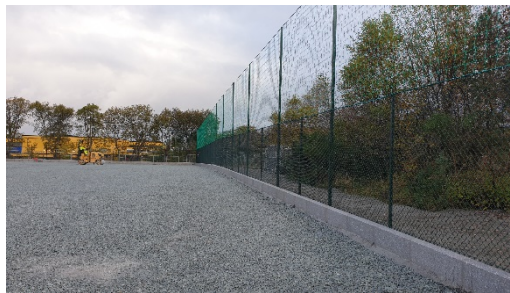
Eksempel: ringmur betong inkl. gjerdestolpe, granittkantstein med stolpe på baksiden
