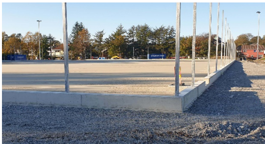
Eksempel: ringmur betong inkl. gjerdestolpe, granittkantstein med stolpe på baksiden
